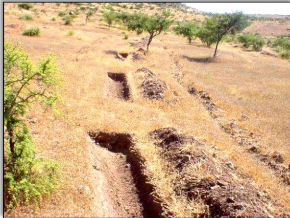
Figura N° 16: Zanjas de infiltración
