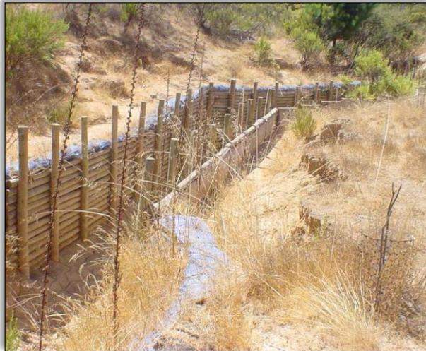
Figura N° 6: Canal recubierto con empalizada
