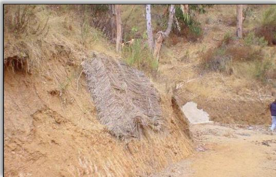
Figura N° 10: Fajina utilizada para proteger un talud
