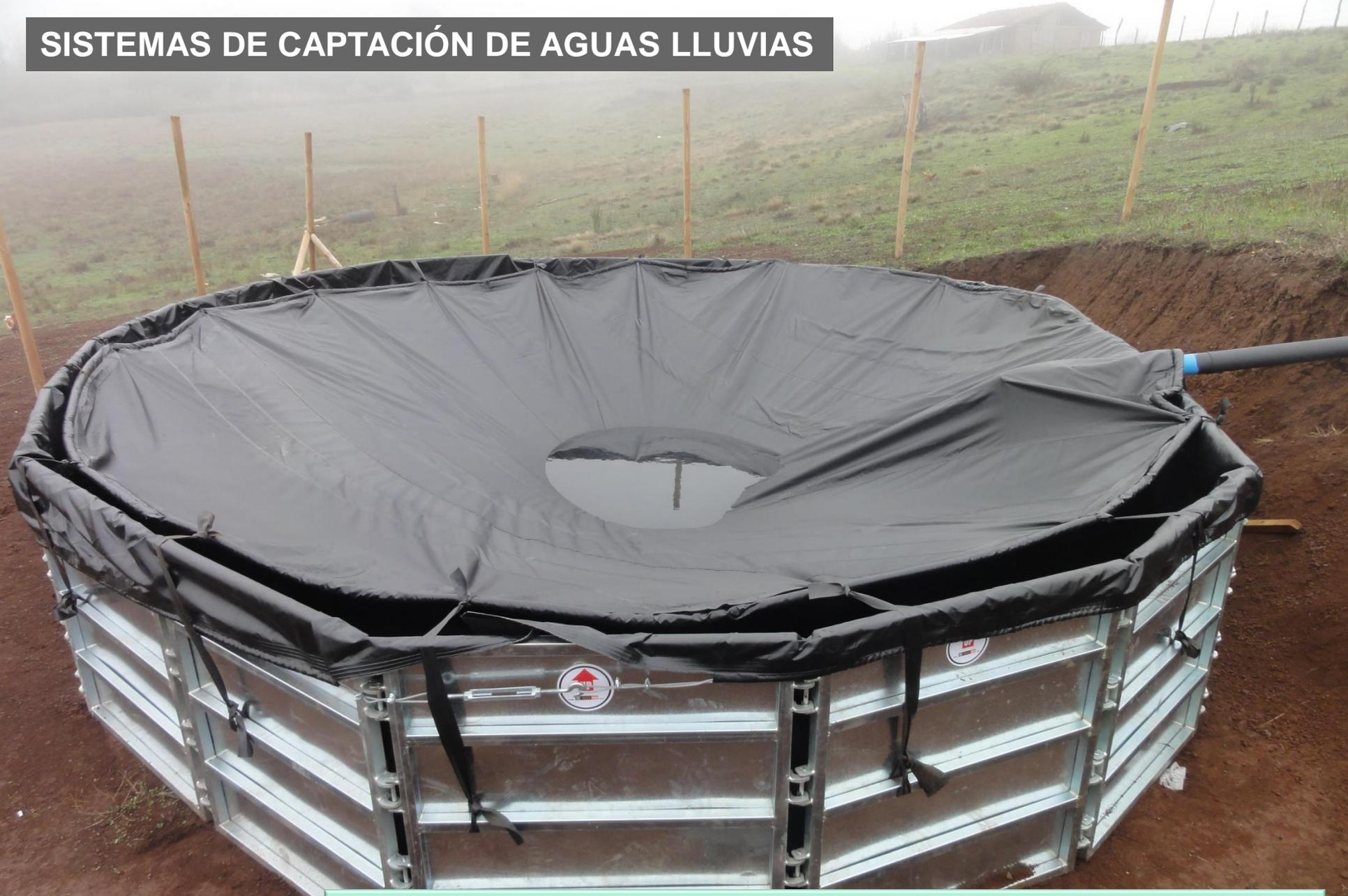
Sistema de captación de geomembrana (95m<sup>2</sup>) y estanque australiano (40m<sup>3</sup>) (Total≈MM\$5,2), Sector Peuño Alto, Comuna de Pelluhue.
