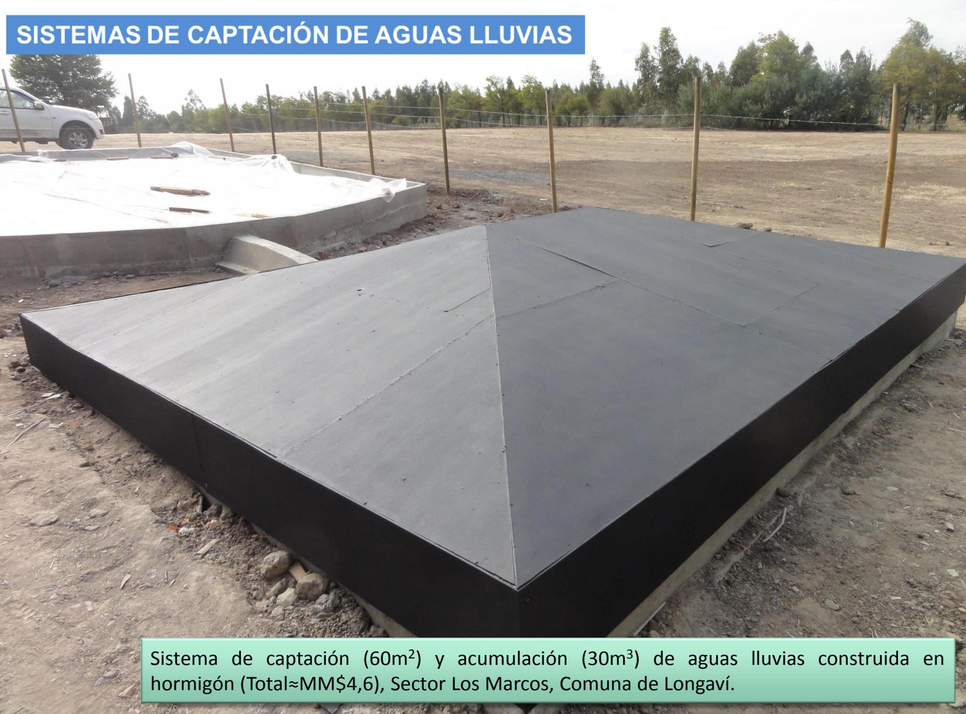
Sistema de captación ( $60\text{m}^2$ ) y acumulación ( $30\text{m}^3$ ) de aguas lluvias construida en hormigón (Total  $\approx$ MM\$4,6), Sector Los Marcos, Comuna de Longaví.
