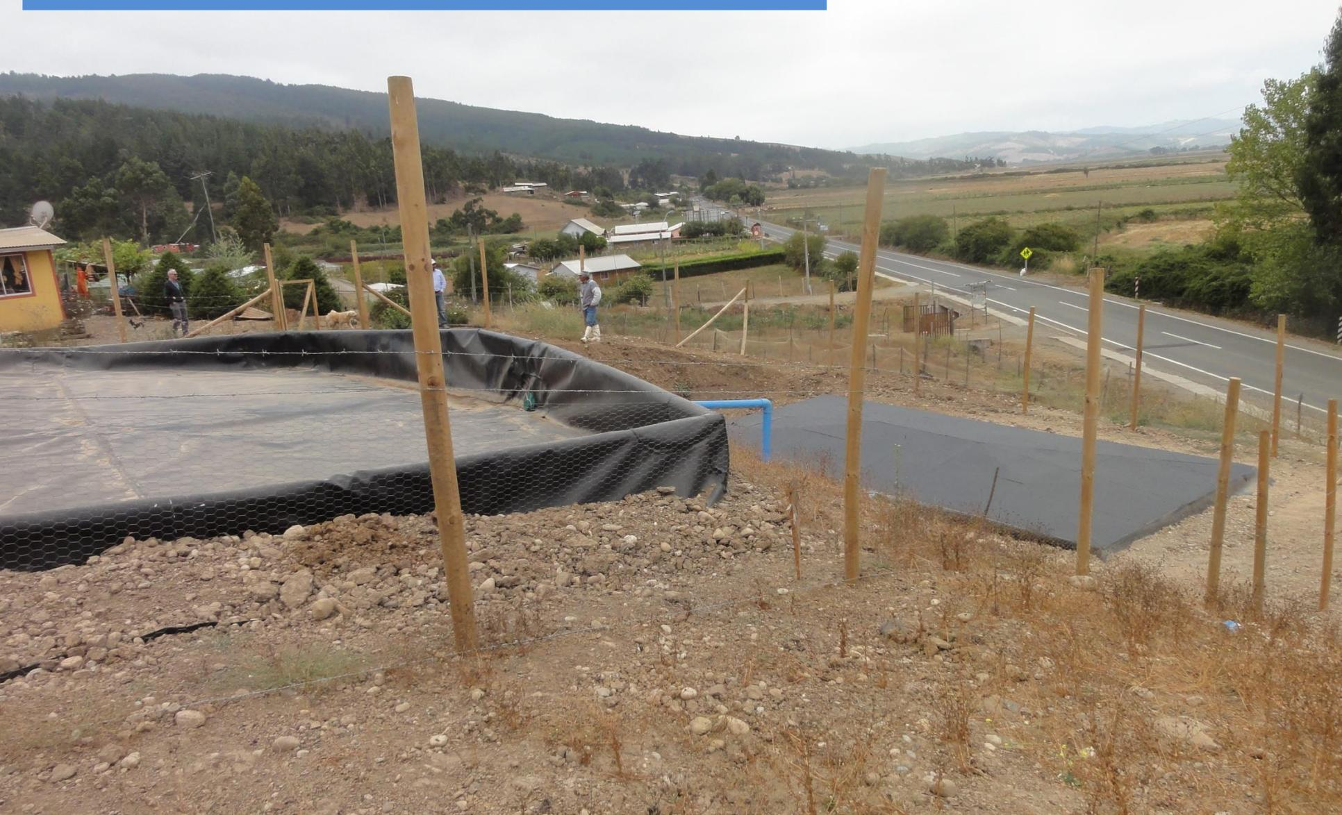
Sistema de captación ( $150\text{m}^2$ ) y acumulación ( $50\text{m}^3$ ) de aguas lluvias construida con geomembrana (Total  $\approx$ MM\$4,6), Sector Huapi, Comuna de Licantén.
