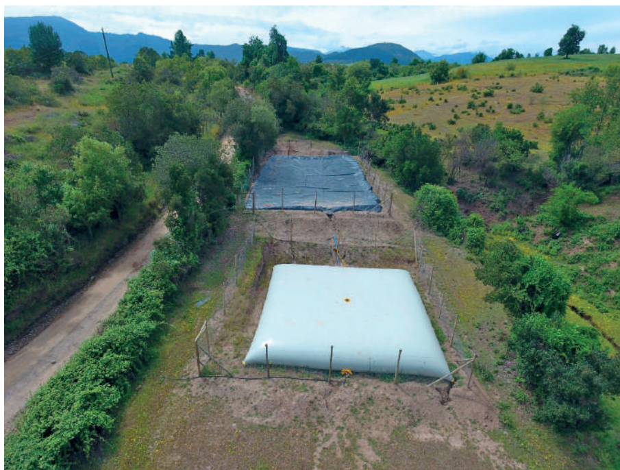
Figura 1: Sistema de captación de aguas lluvias (SCALL) con geomembrana en área de captación y estanque flexible como cisterna acumuladora en la zona baja.
