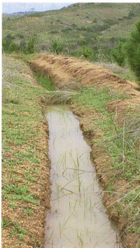
Figura 8: Zanjas de Infiltración
