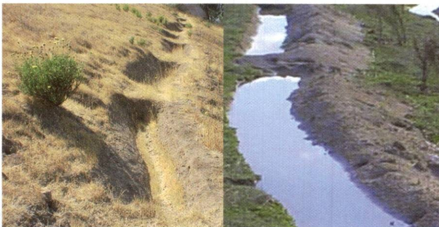
Figura 13: Mantenimiento Zanjas de Infiltración
