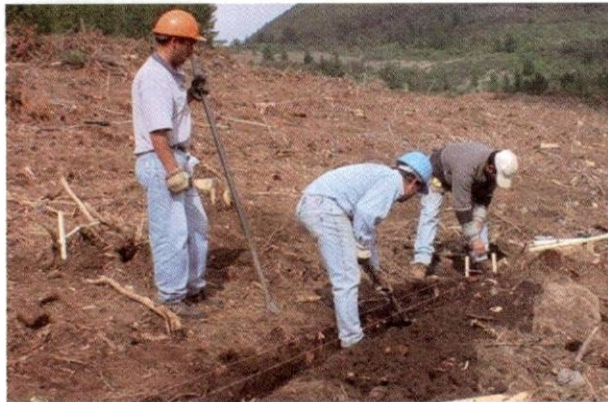
Figura 7: Construcción de Canal de Desviación en terreno
