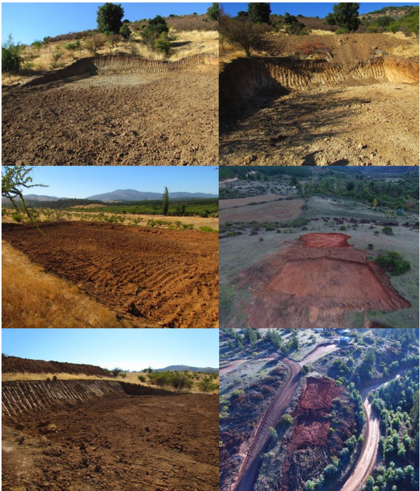
Figura 3: remoción de tierra y aplanamiento de los sitios para instalación de la geomembrana.
