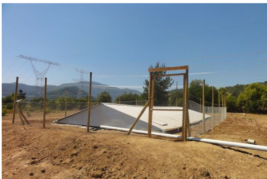
Figura 29: sistema de captación de aguas lluvias instalado por INDAP y usado en el proyecto. Sector Carrizalillo, San Clemente.
