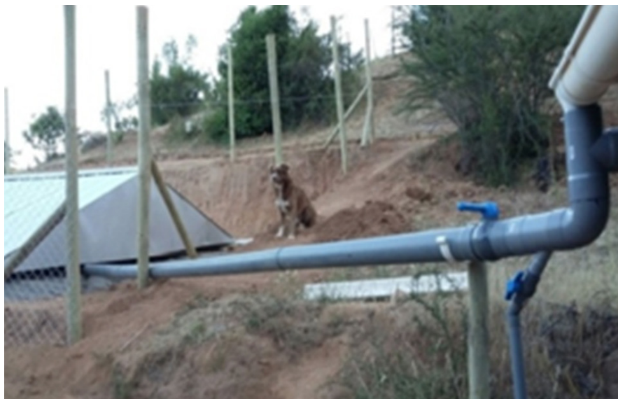
Figura 30: sistema de captación de aguas lluvias instalado por INDAP y usado en el proyecto. Sector Colmenares, Empedrado.
