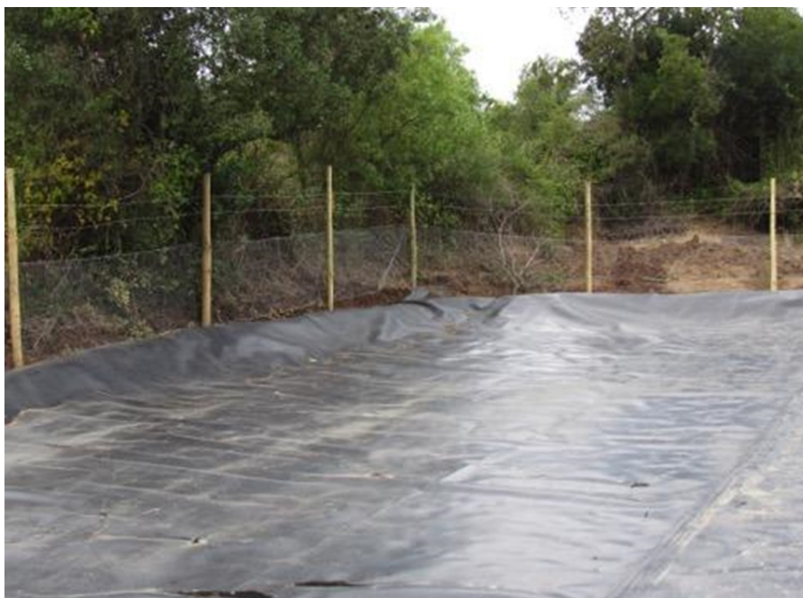
Figura 25: área de captación de geomembrana, sector Rincón de los Muñoces, San Clemente.
