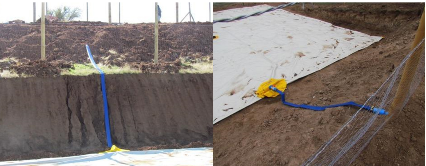
Figura 5: mangueras de conexión desde el área de captación hacia el estanque flexible.
