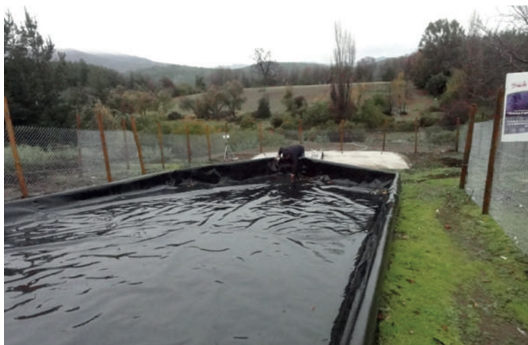
Figura 1: sistema de captación de aguas lluvias diseñado por el Centro Tecnológico de Hidrología Ambiental de la Universidad de Talca
