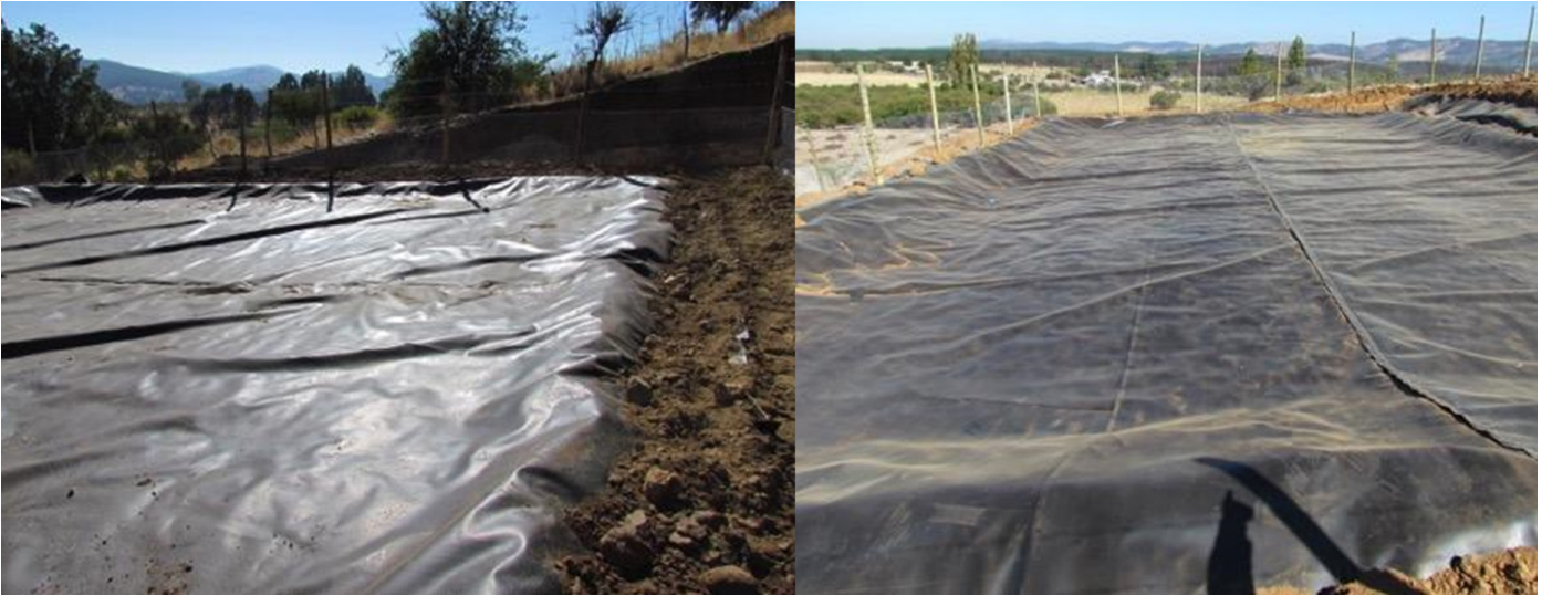
Figura 4: geomembranas enterradas en las canaletas
