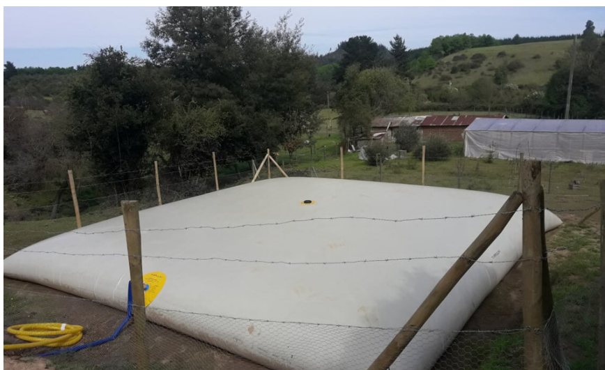
Figura 27: estanque flexible del sector Rincón de los Muñoces, San Clemente.
