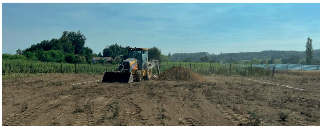
Figura 11. Nivelación y excavación en terreno unidad de Coihueco.
