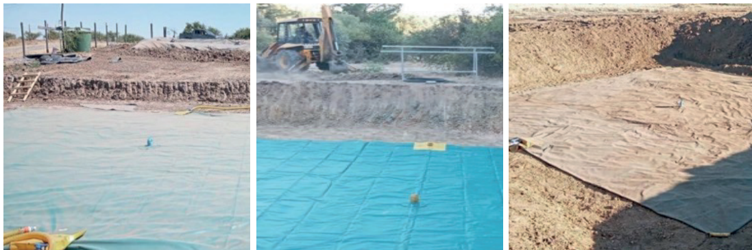
Figura 14. Excavaciones del terreno, de izquierda a derecha: Ñiquén, San Carlos y Coihueco.
