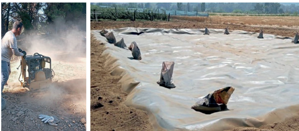
Figura 13. Compactación de terreno en unidad de San Carlos e instalación de la geomembrana en la unidad de Coihueco.
