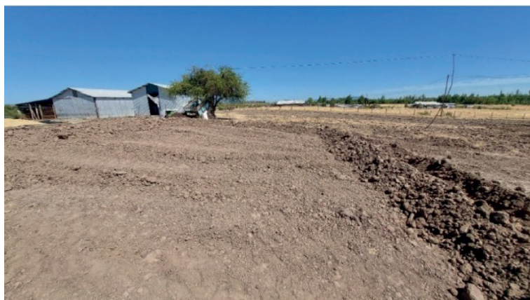
Figura 12. Conformación de talud unidad de Niquén.
